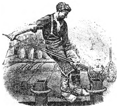
Pouring Crucible Steel.
